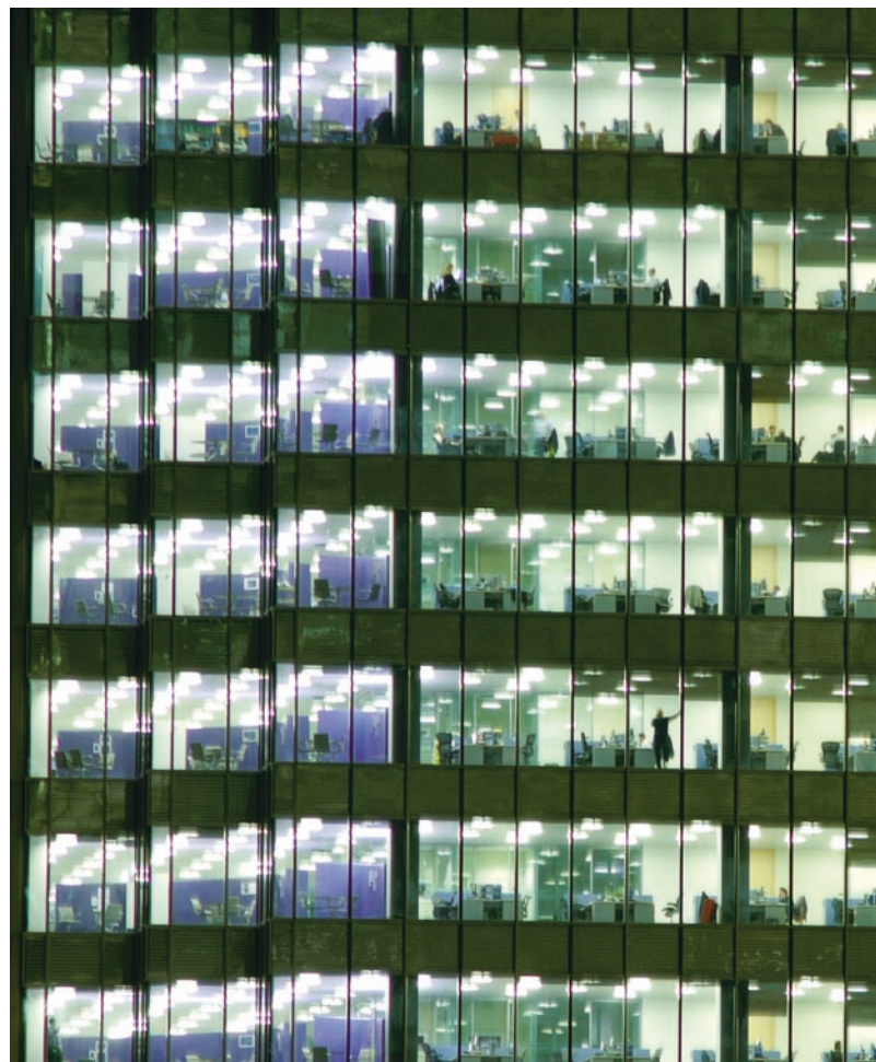
In kantoorpanden is eenvoudig tot 30 procent op energie te besparen.
